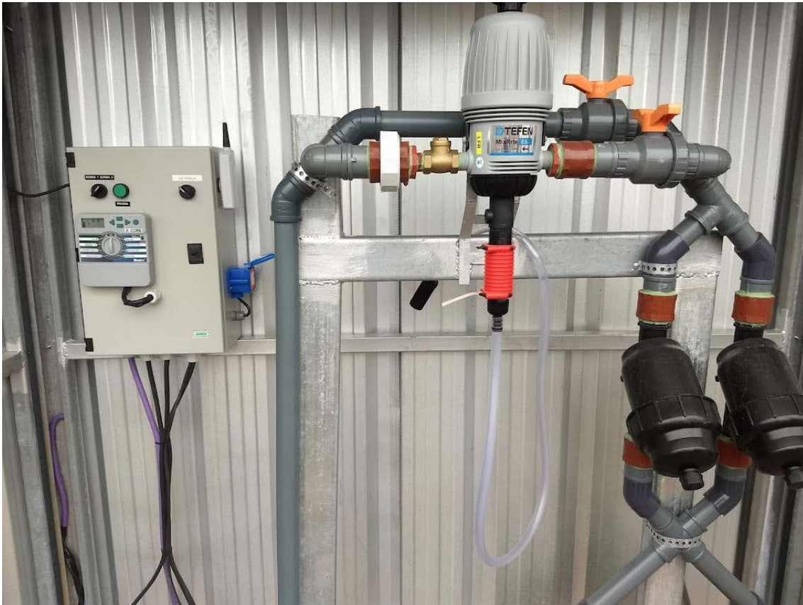
Figura 11: Equipo de programación y bombeo de agua y fertilizantes
